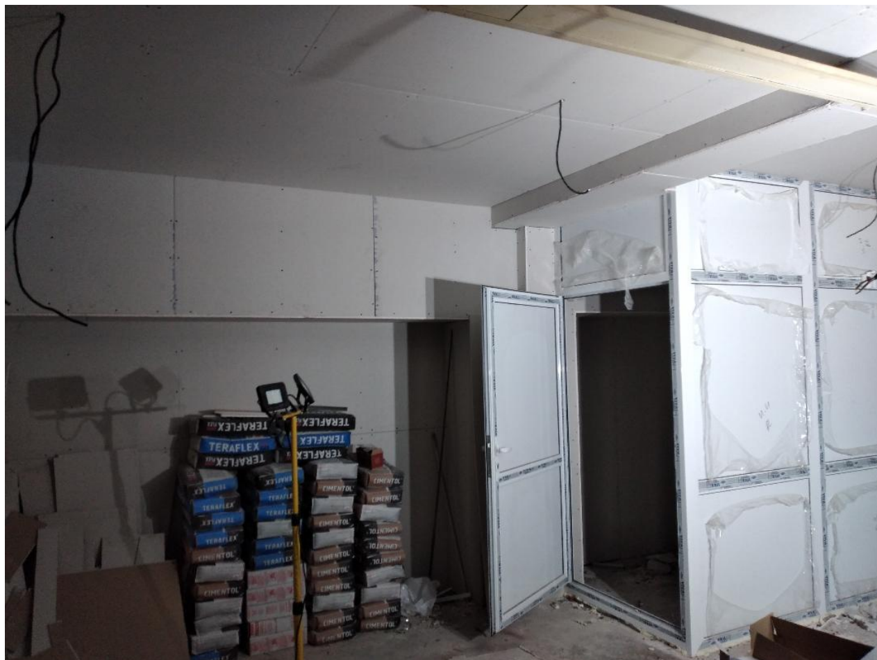
Фиг. 2. Дейности по ремонта и изграждането на фемтосекундна лаборатория в ИЕ-БАН към дата 15 април 2021 година. В лабораторията се изгражда допълнително помещение за преобличане на персонала в подходящо облекло за работа в чиста стая.
